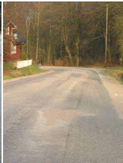
Figur 5: Lösgrus efter lagningsarbete medför särskild fara för mc
